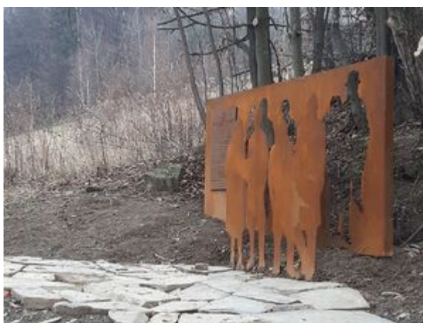
Pomnik w Popardowej w trakcie budowy
