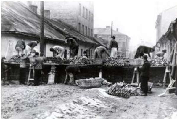
Budowa muru getta w Podgórzu. Fot. ze zbiorów IPN w Krakowie
