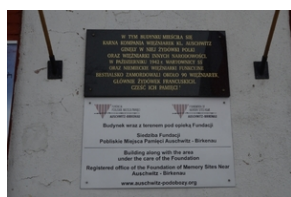
27.01.2021. Budynek w Brzeszczach Borze, gdzie mieściła się karna
