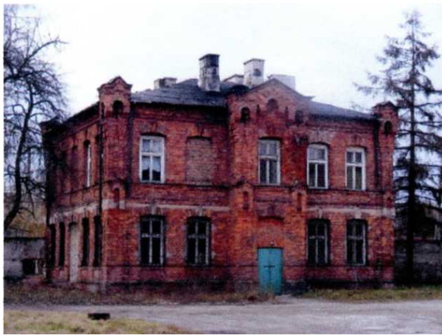
Budynek więzienia widok obecny (front)
