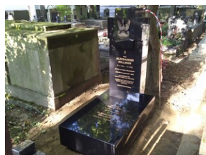
Nagrobek po remoncie
